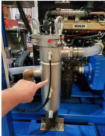
Localize o filtro principal, remova os 3 parafusos de arco na parte superior para abrir
