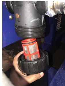
Figura 6.1 - Filtros de inspeção / limpeza de água
